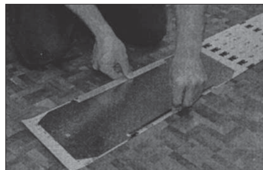
Obr. 15 Formát brusiva vyřízněte přesně podle šablony dodané v příslušenství.
